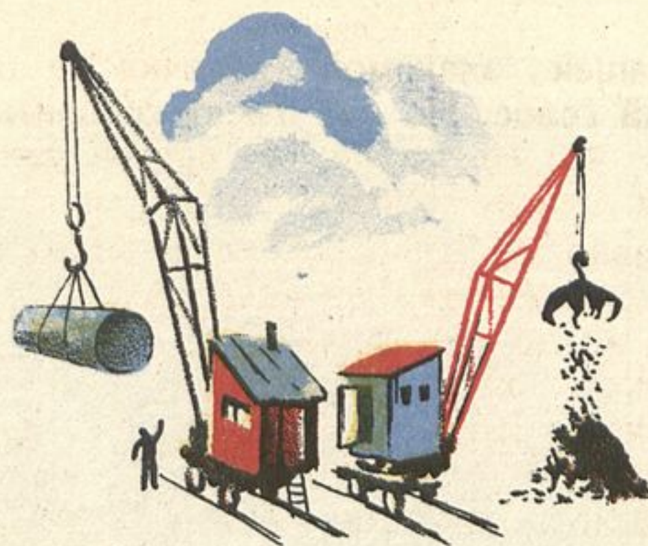
Подъёмный кран помогает рабочим укладывать в землю огромные тяжёлые трубы.
